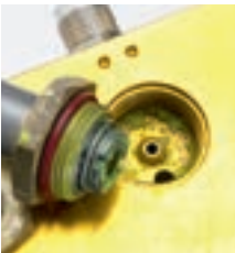
Contamination par mastic dans la station d’entretien de climatisation sans l’utilisation du Recycle Guard
